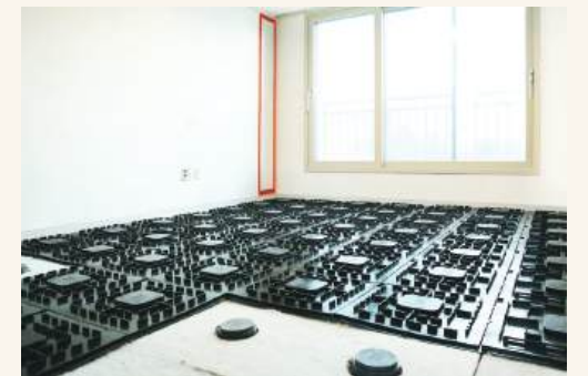
④ 받침판 설치
