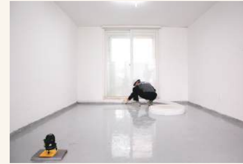
① 측면 완충재 설치
