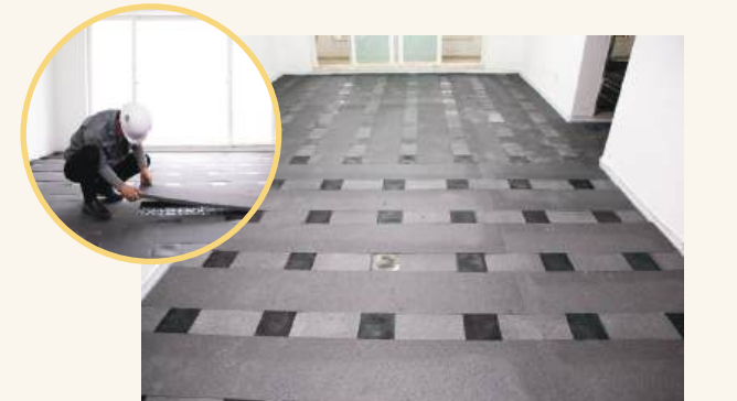
⑤ 단열재 설치
