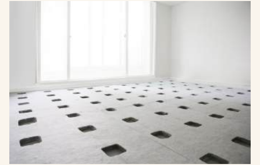
② 단열재 설치
