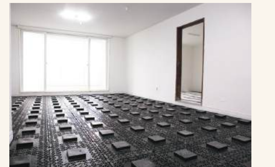
④ 완충재 설치 전경
